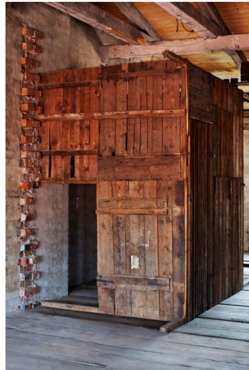
Teile des Kuriositätenkabinetts sollen sich in diesem Verschlag befinden haben.
